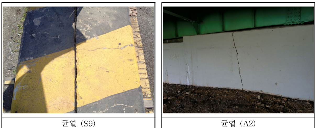
【그림 7.3】 균열 외관조사 현황
